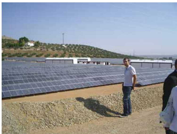
Figura 3.5 - Veduta parziale del PVPP da 9,2-MWp di Jaén (fattoria solare ‘Uliveti’).
